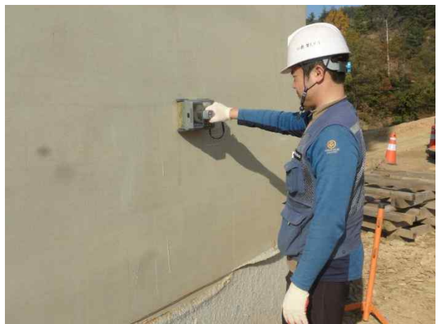
P6(상주방향) 기둥부 철근배근탐사 전경
