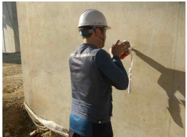
P10(상주방향) 기둥부 반발경도시험 전경
