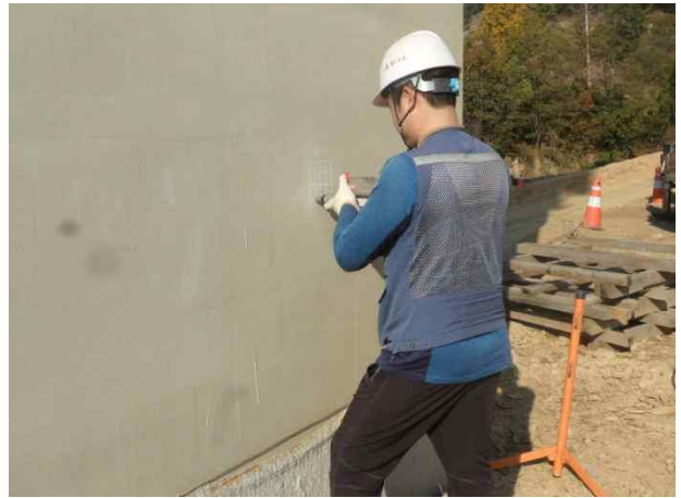
P6(상주방향) 기둥부 반발경도시험 전경
