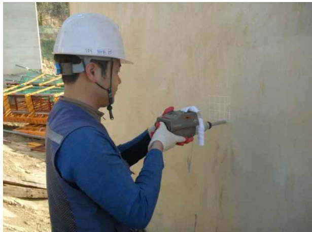
P7(영천방향) 기둥부 반발경도시험 전경
