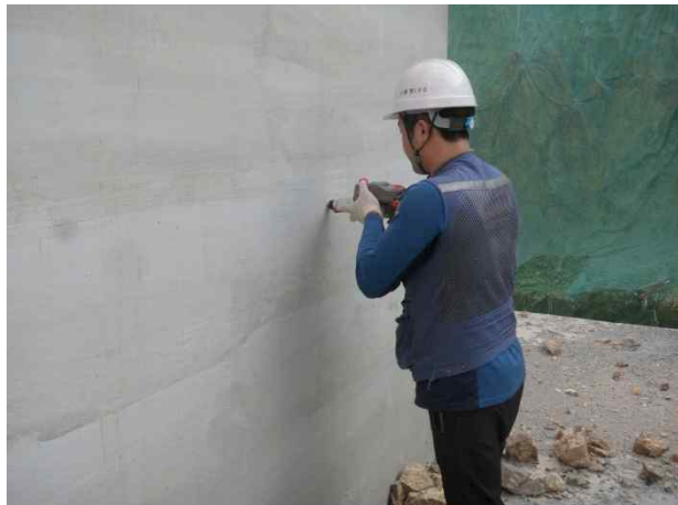
P1(영천방향) 기둥부 반발경도시험 전경
