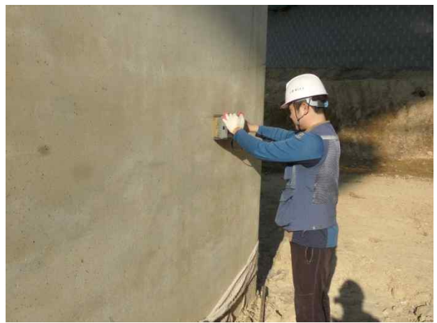
P10(상주방향) 기둥부 철근배근탐사 전경
