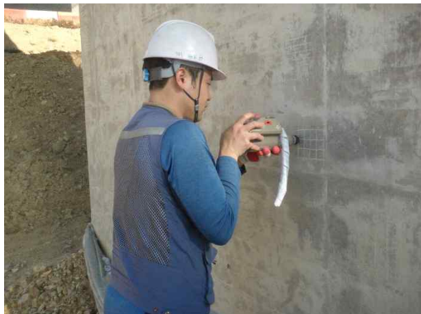
P9(영천방향) 기둥부 반발경도시험 전경
