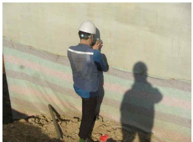
P4(영천방향) 기둥부 반발경도시험 전경
