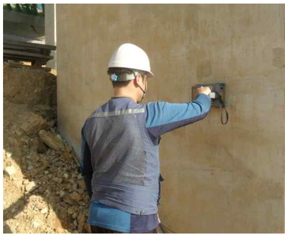
P8(영천방향) 기둥부 철근배근탐사 전경
