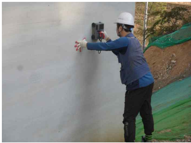
P2(영천방향) 기둥부 철근배근탐사 전경
