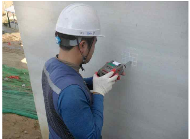
P2(영천방향) 기둥부 반발경도시험 전경
