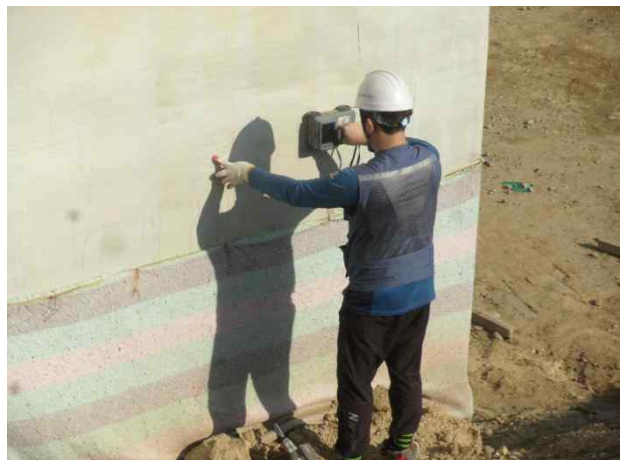
P4(영천방향) 기둥부 철근배근탐사 전경
