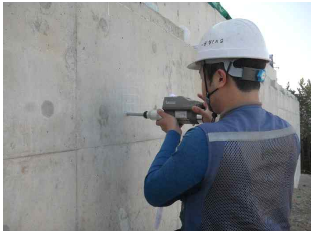
A1(영천방향) 벽체전면 반발경도시험 전경
