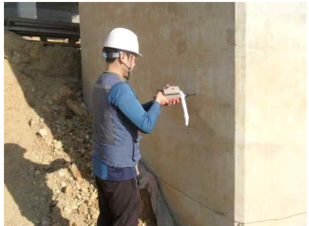
P8(영천방향) 기둥부 반발경도시험 전경
