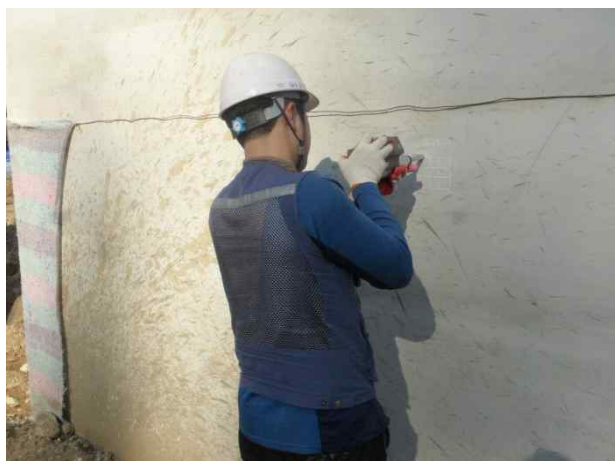
P3(상주방향) 기둥부 반발경도시험 전경
