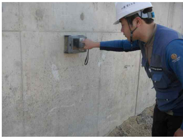
A2(영천방향) 벽체전면 철근배근탐사 전경
