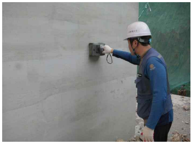
P1(영천방향) 기둥부 철근배근탐사 전경
