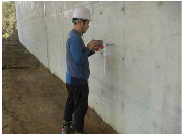
A2(영천방향) 벽체전면 반발경도시험 전경
