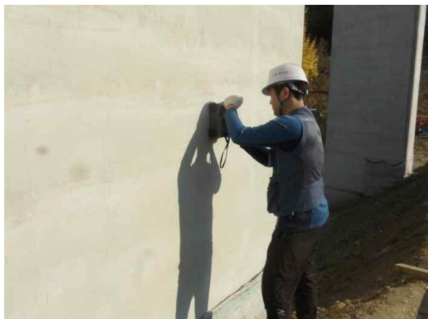
P5(상주방향) 기둥부 철근배근탐사 전경
