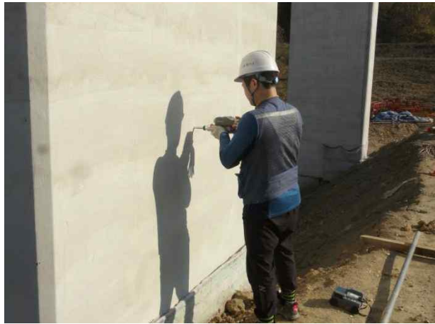
P5(상주방향) 기둥부 반발경도시험 전경
